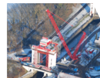
Photo left: Lock Twentekanaal Eefde, NL
